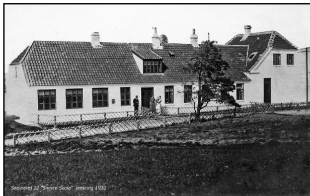
Snevre Skole som den så ud efter udbygningen.
