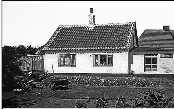
Huset, der blev revet ned i 1956.
